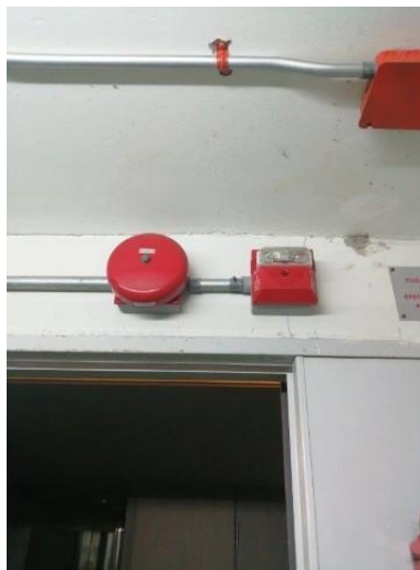
ภาพแสดง : เครื่องส่งสัญญาณเตือนภัย (Fire Alarm Bell)
